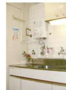
共用部/給湯室
